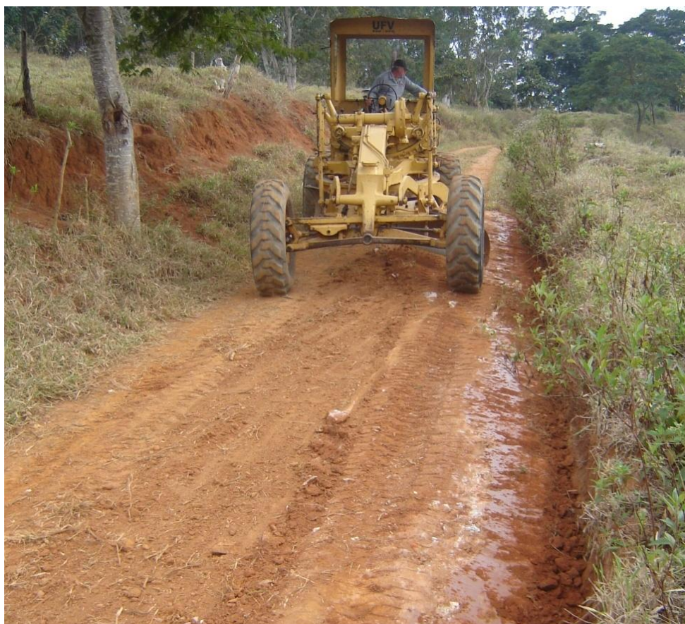
Figura 16 - Adequação do leito da estrada.
