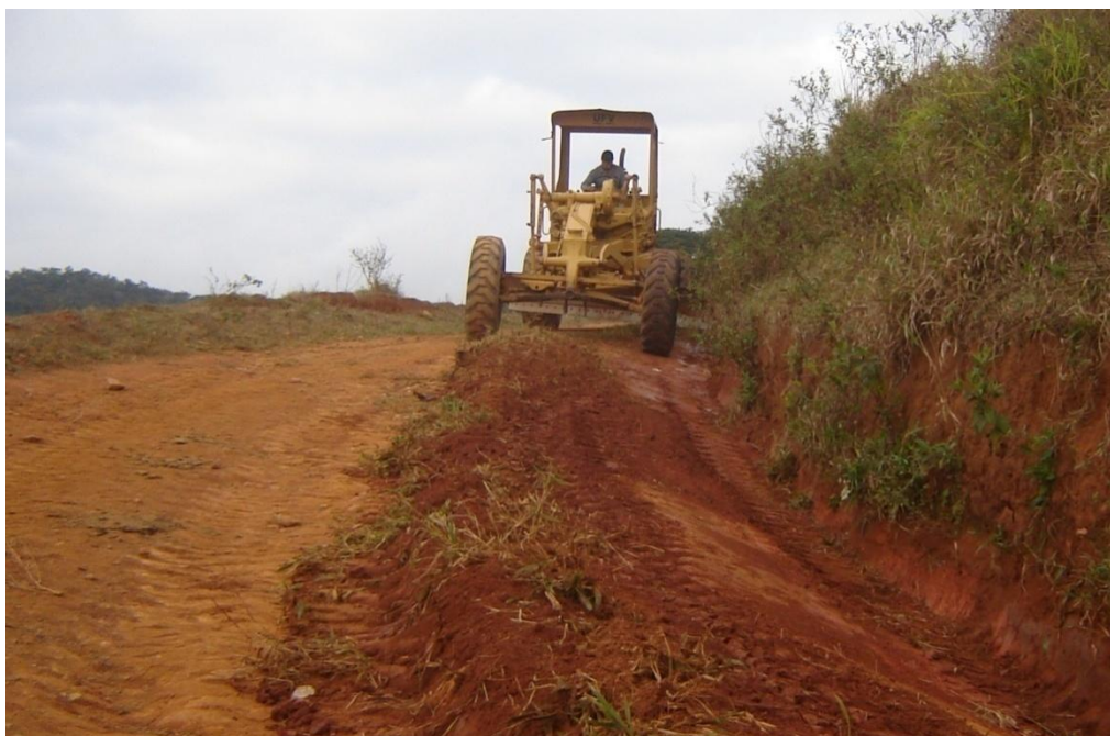
Figura 17 - Construção do canal de drenagem da estrada.
