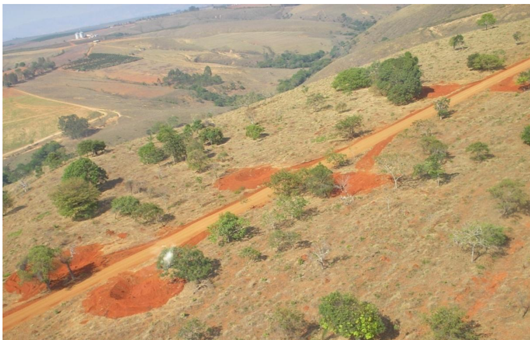
Figura 4 - Bacias de infiltração para a contenção do escoamento superficial em estradas não pavimentadas.
