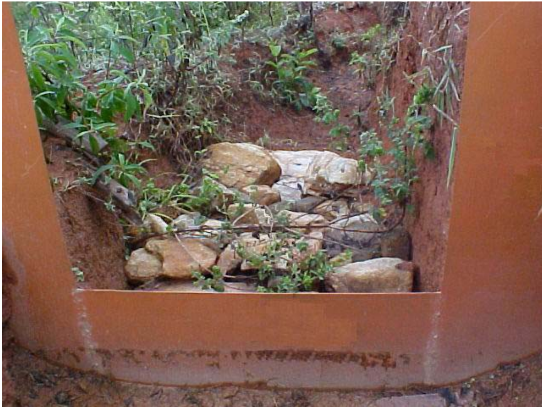
Figura 31 - Vertedor retangular instalado no canal situado na seção de deságüe da bacia hidrográfica estudada.
